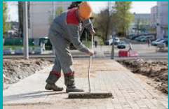
Nettoyage chantier BTP
